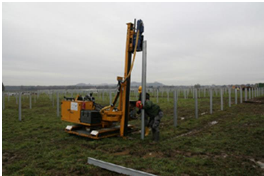
Zdjęcie 2. Montaż profili za pomocą kafara.
