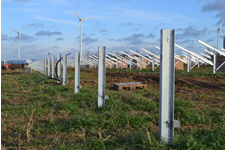
Zdjęcie 1. Profile metalowe: podstawowy element konstrukcji.
