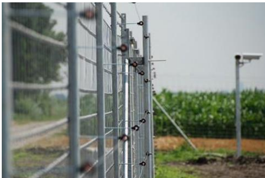
Zdjęcie 7. Przykładowe ogrodzenie farmy fotowoltaicznej.
