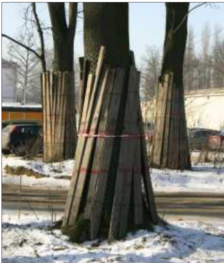
Fotografia 1 Przykładowy sposób ochrony pnia drzewa przed uszkodzeniami mechanicznymi
