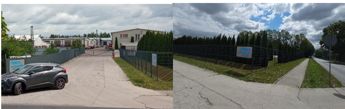
Fot. 6. Teren objęty sporządzanym planem, budynki firmy Trimco – przy drodze wojewódzkiej Źródło: fotografia własna
