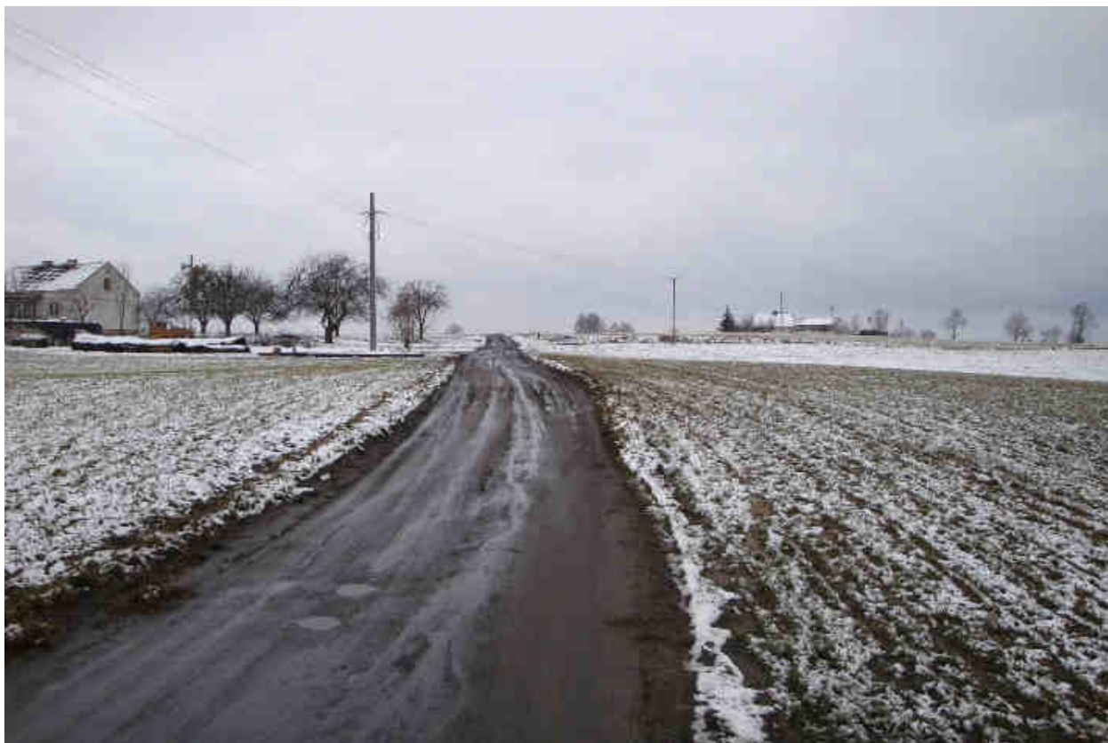
Luźno rozproszona, niska zabudowa zagrodowa w sąsiedztwie istniejącej drogi do modernizacji
