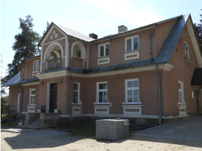
Zdjęcie 38 Jeden z budynków wchodzących w skład zabytkowego zespołu kościoła parafialnego w Sadłowie
