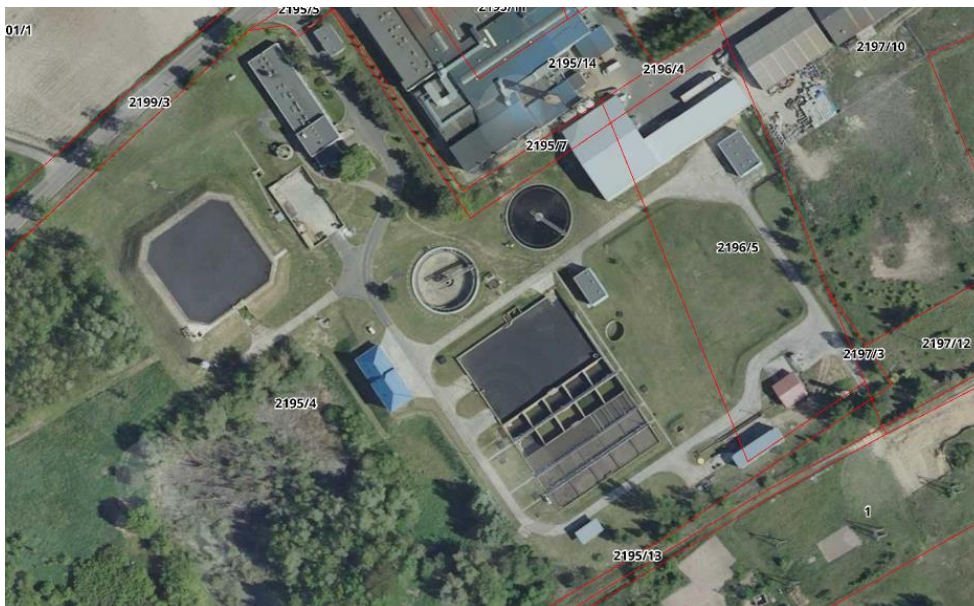
Rysunek 23 Miejska oczyszczalnia ścieków w Rypinie
