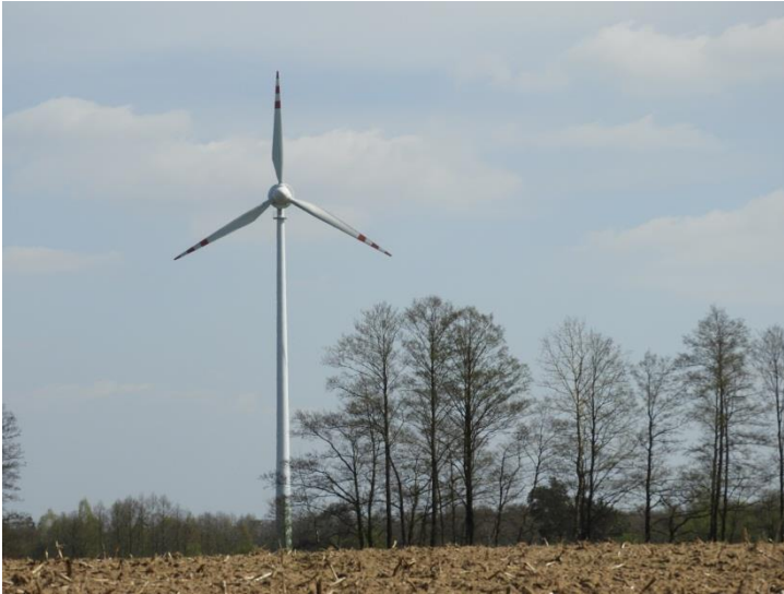
Zdjęcie 58 Elektrownia wiatrowa w Puszczy Rządowej
