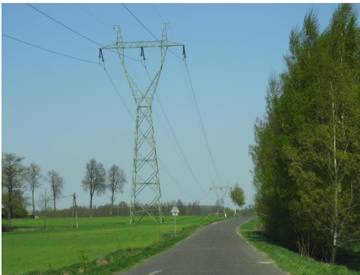
Zdjęcie 54 Linia elektroenergetyczna wysokiego napięcia w Sadłowie
