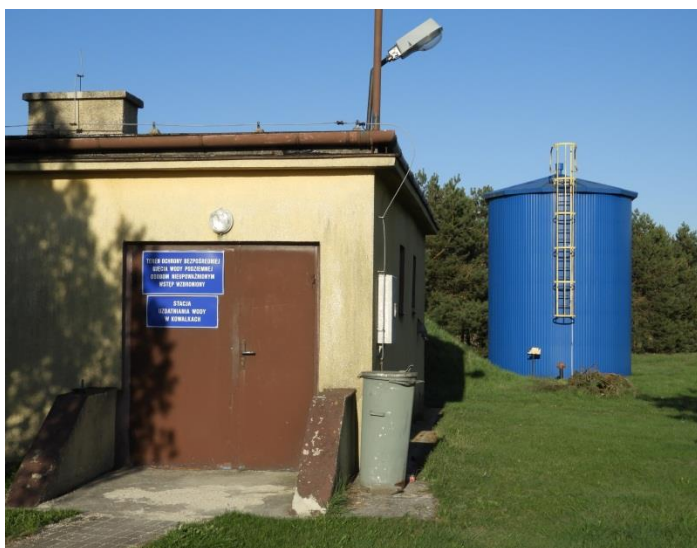
Zdjęcie 50 Gminne ujęcie wody w Kowalkach
