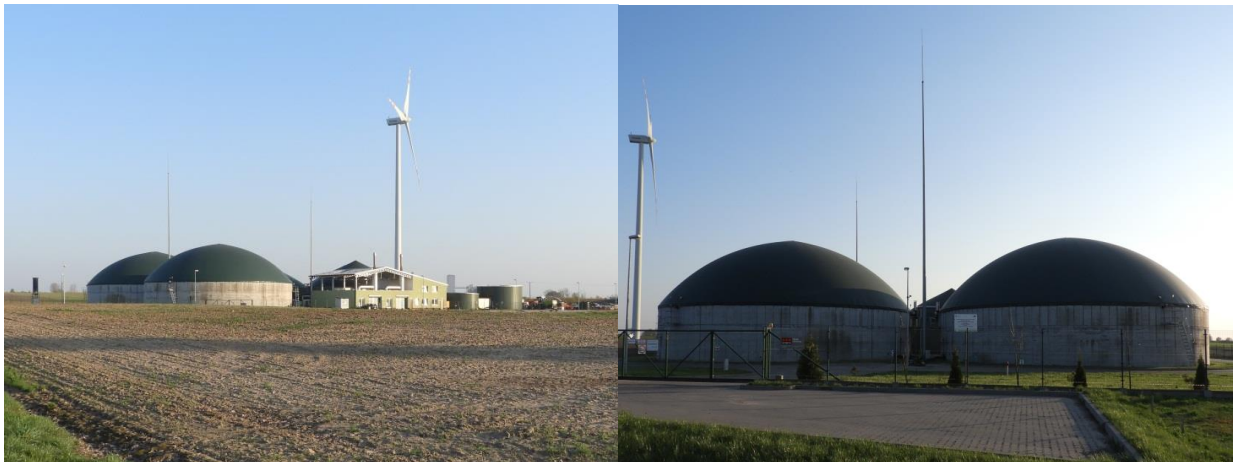
Zdjęcie 61 Biogazownia w Starorypinie Prywatnym
