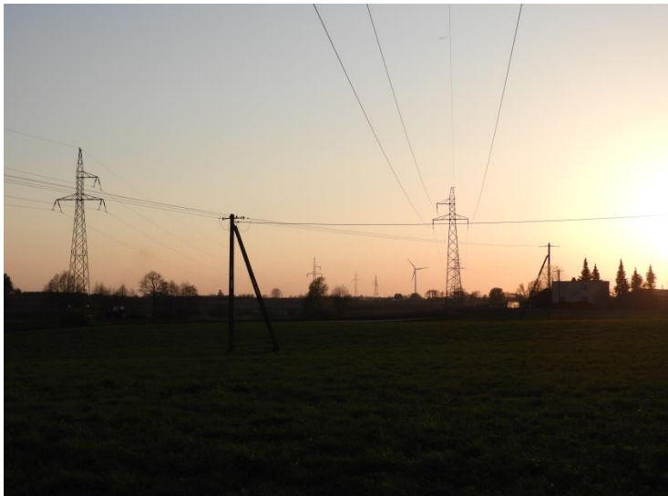
Zdjęcie 52 Zagęszczenie infrastruktury elektroenergetycznej w okolicach m. Ławy
