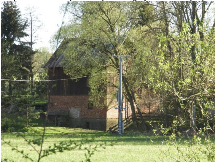
Zdjęcie 60 Murowano-drewniany młyn wodny w Dylewie – Prątni
