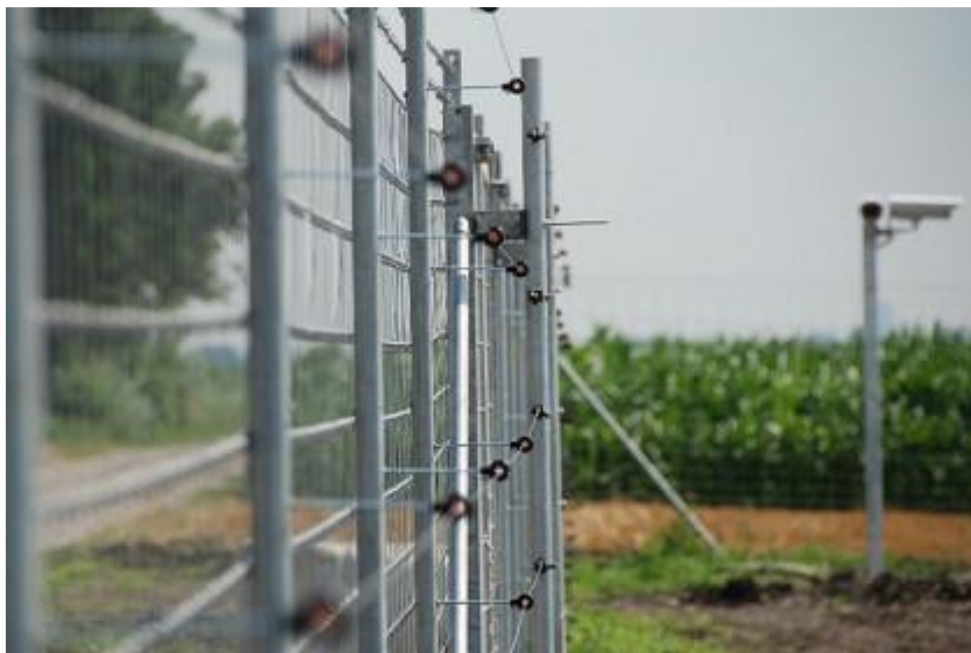
Rysunek 4 Przykładowe ogrodzenie farmy fotowoltaicznej
