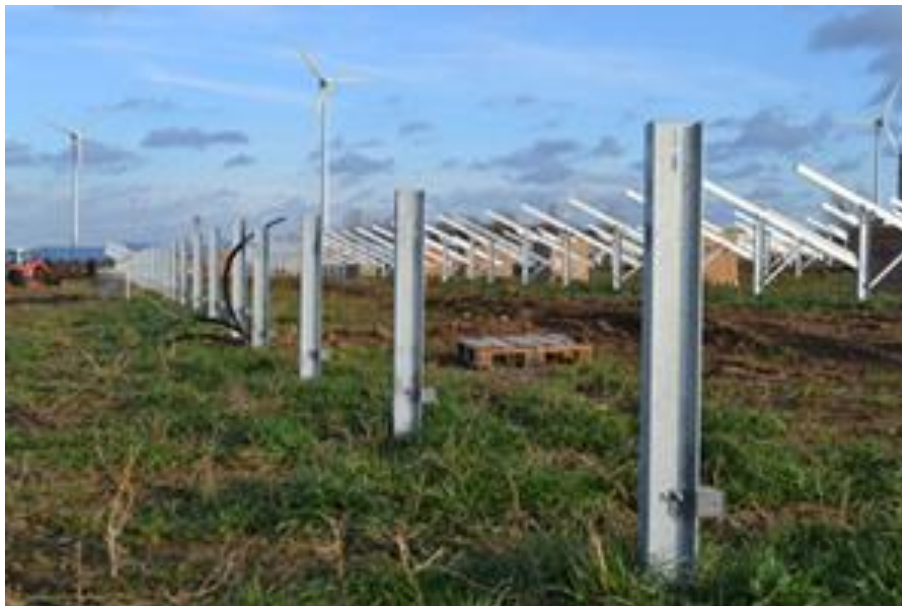
Zdjęcie 2 Profile metalowe: podstawowy element konstrukcji.
