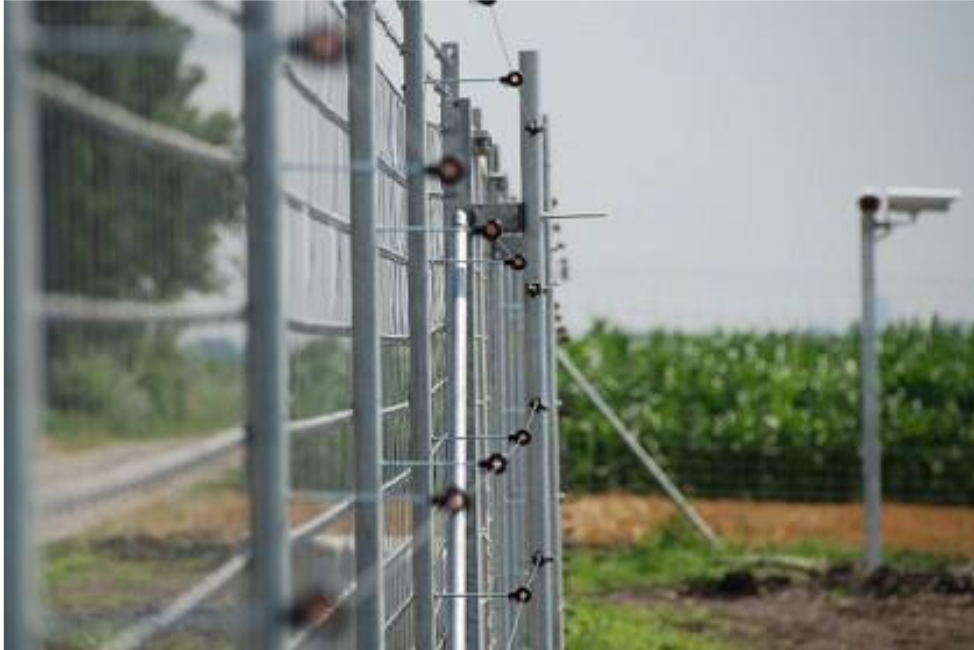
Rysunek 4 Przykładowe ogrodzenie farmy fotowoltaicznej
