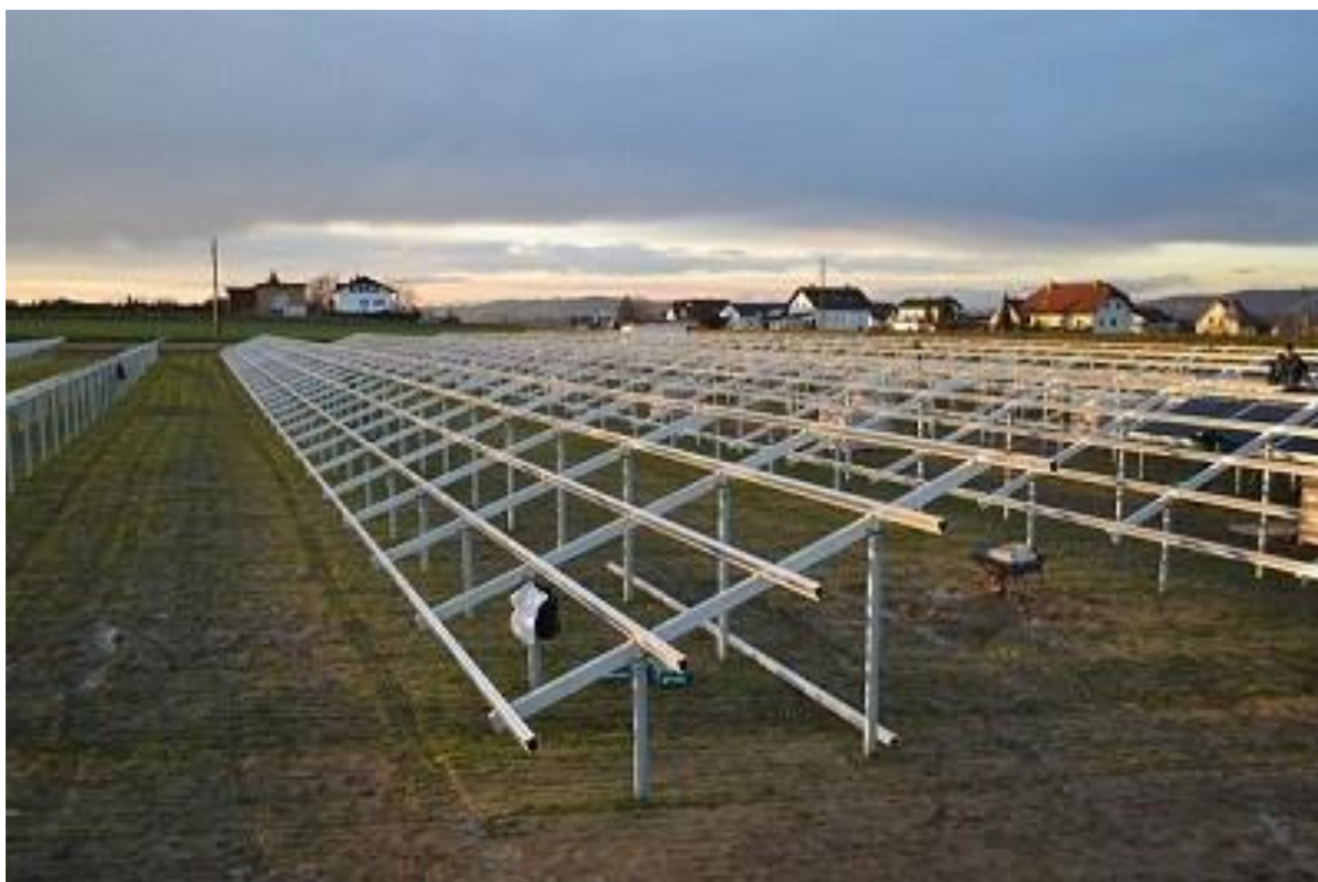
Rysunek 6 Szkielety przed montażem paneli, farma solarna NIENBURG 4 MW (Niemcy) (Remor Solar).
