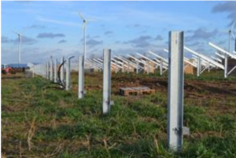
Zdjęcie 2 Profile metalowe: podstawowy element konstrukcji.
