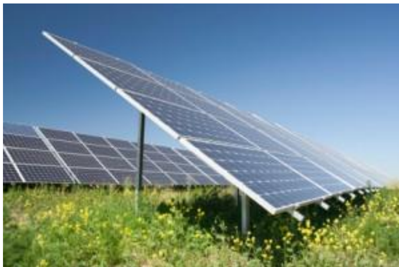
Rysunek 5 Sposób montażu paneli fotowoltaicznych na stelażach wbijanych bezpośrednio do gruntu.
