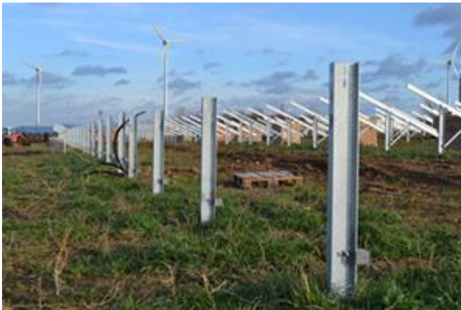
Zdjęcie 2 Profile metalowe: podstawowy element konstrukcji.
