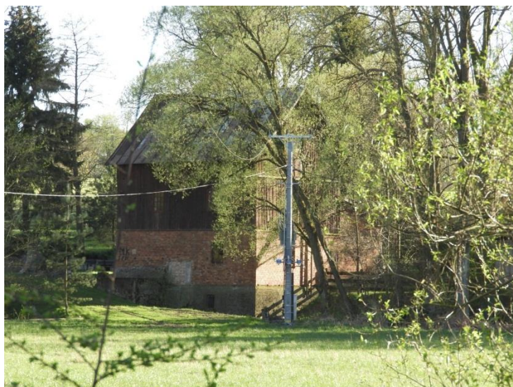
Fot. 7. Murovano-drewniany młyn wodny w Dylewie – Prątni
