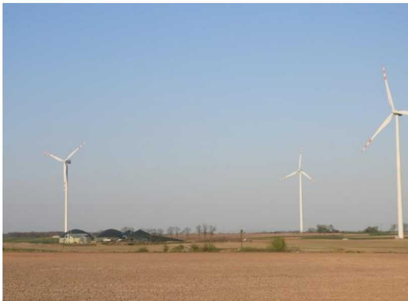
Fot. 5. Elektrownie wiatrowe i biogazownia w Starorypinie Prywatnym Źródło: Opracowanie Ekofizjograficzne na potrzeby studium uwarunkowań i kierunków zagospodarowania przestrzennego Gminy Rypin, maj 2018
