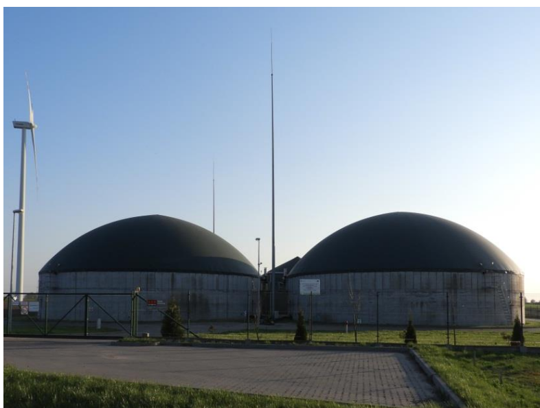
Fot. 8 Biogazownia w Starorypinie Prywatnym
