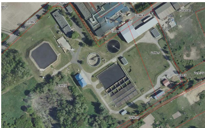
Ryc. 15. Miejska oczyszczalnia ścieków w Rypinie
